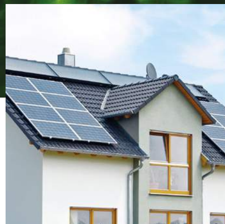
MODUŁY I INWERTERY FOTOWOLTAICZNE
